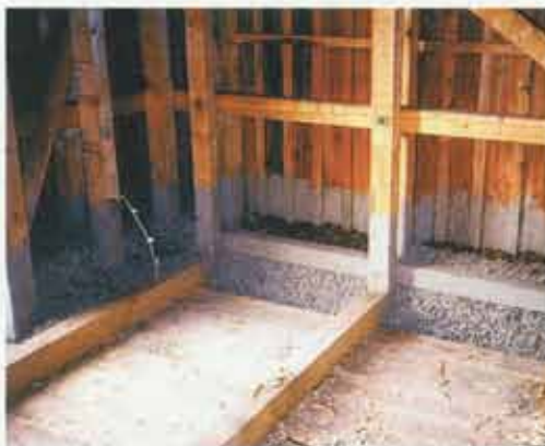
Beginnende Ausfachung mit Holzschindel-Leichtlehm bei der Außenwand (Foto: Planungsbüro für gesundes Bauen)
